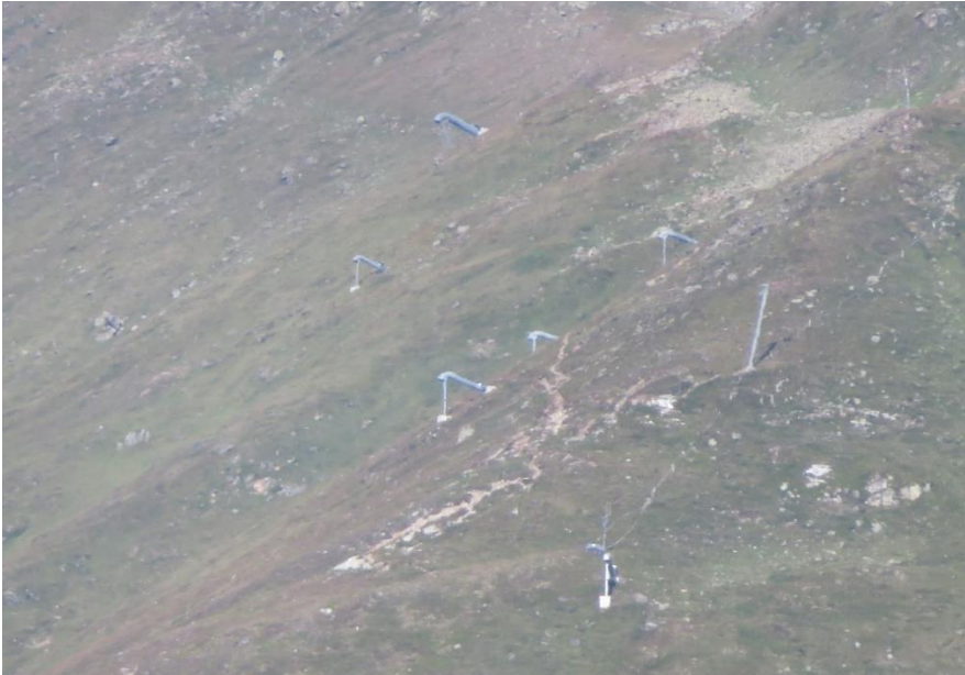
Abbildung 3-2: Zündrohre im Nahbereich einer Skipiste, Foto: Umgeher (Revital)
